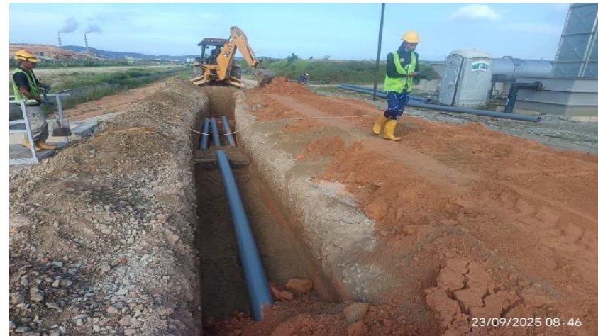
Rajah 4: Penanaman paip wayar elektrik
