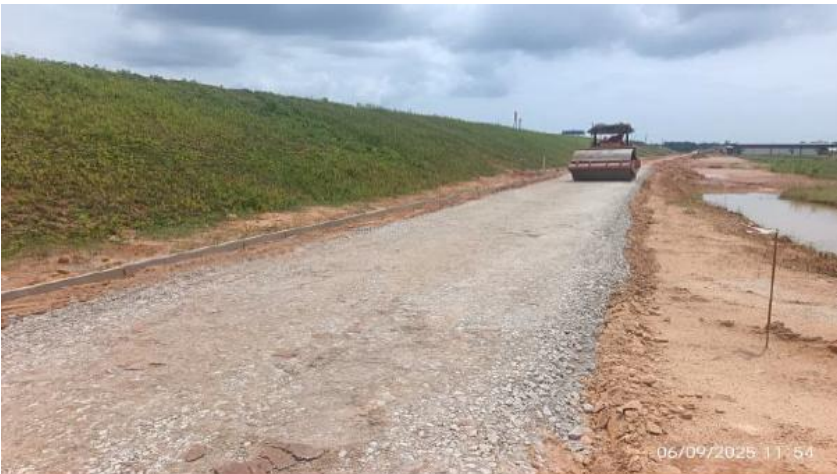
Rajah 3: Pembinaan jalan raya pada lingkaran Tengah
